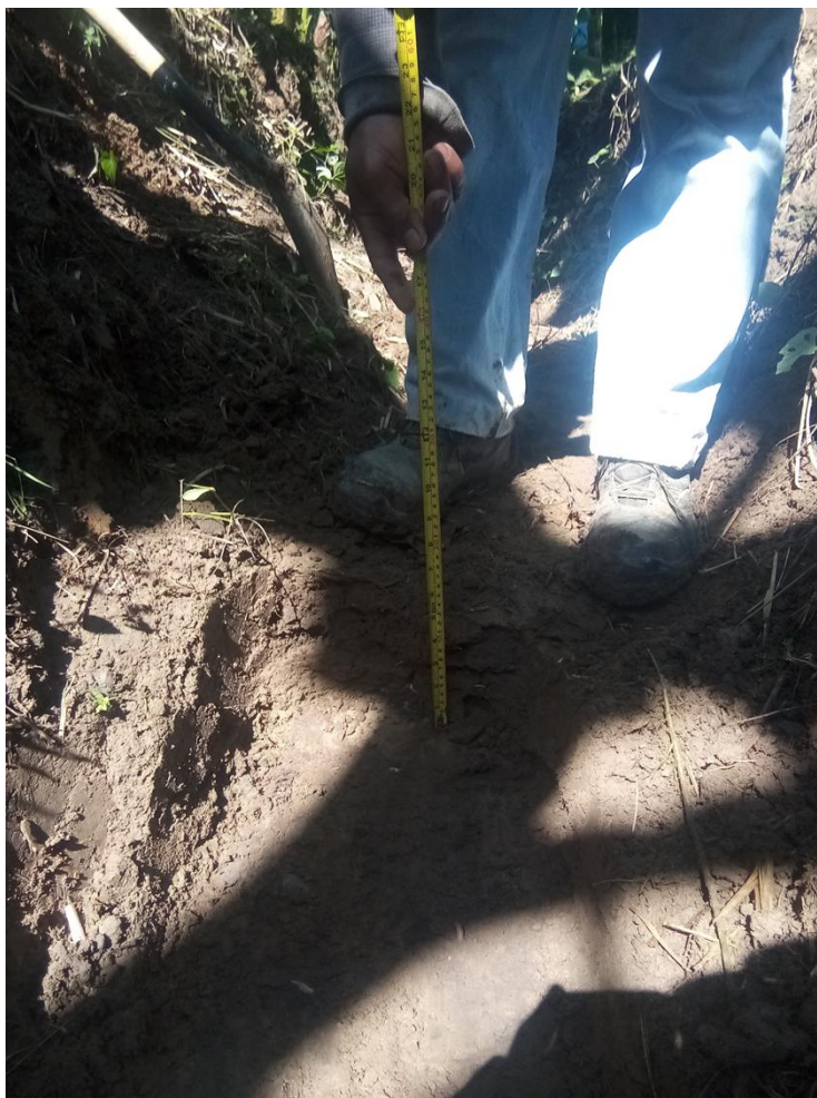
Ilustración 5 Medición de profundidad al desazolve de drenajes. Se señala la profundidad del corte ya sea por tramos o ha lo largo del drenaje, según condiciones.
