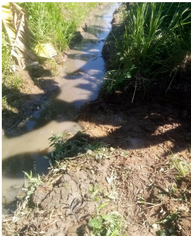
Ilustración 2. Retiro de topes a pala.
