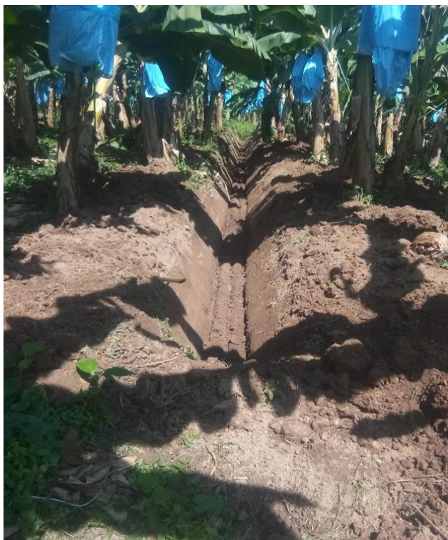
Ilustración 1. Drenaje terciario desazolvado a máquina.
