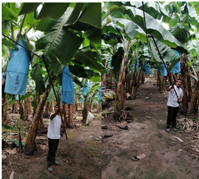
Fig. 6 y 7- Despeje del cable vía, eliminar la porción de la hoja que está sobre el cable.
